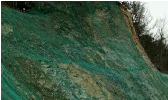
제품명 : KL-NM3030(낙석방지망, 비포켓식) SIZE : W3000×H3000 G2B NO. : 25291037 인도조건 : 납품장소하차도
