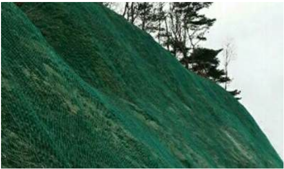
제품명 : KL-NM2030(낙석방지망, 포켓식) SIZE : W2000×H3000 G2B NO. : 25291034 인도조건 : 납품장소하차도
